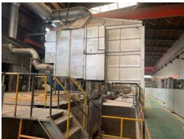
现有工程中频炉现状
