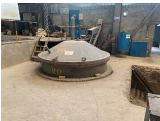
本技改工程 AOD 炉拟建地现状（拆除现有 VD 炉）
