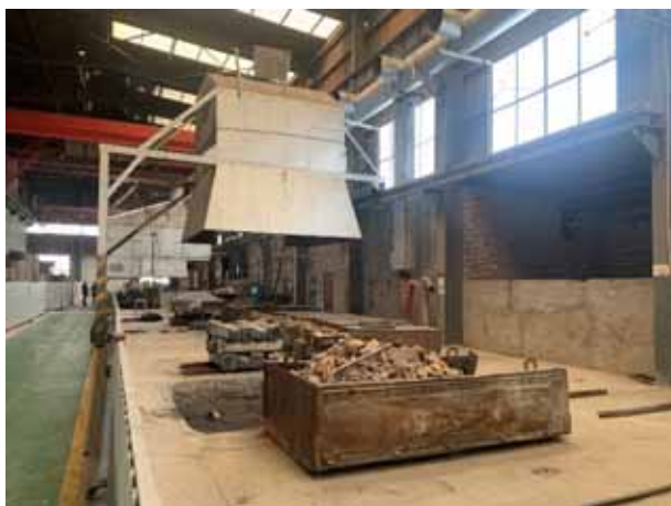
现有工程浇注区现状
